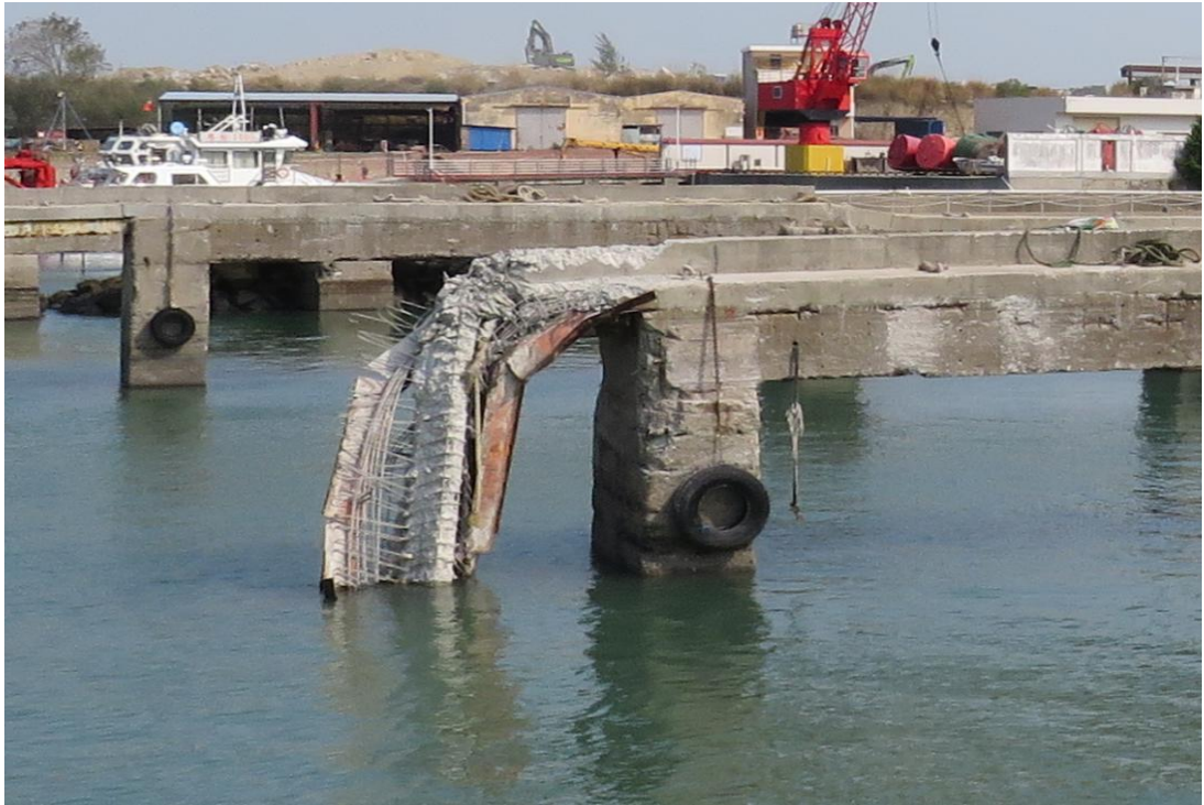
图 3 事故当天工作桥施工位置
