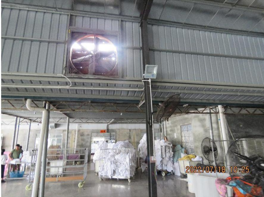
图 2 事故故障的排气扇
